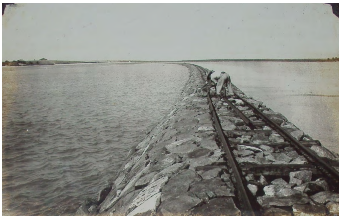
Figura 50. Construção da guia-corrente, 1927. Do lado esquerdo, é possível ver a extensão represada de água que se tornou, paulatinamente, em uma área de mangue e de praia.
