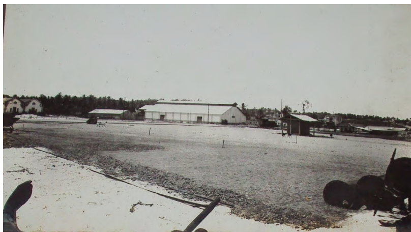
Figura 48. Regularização do aterro por detrás do cais, 1927. Após o aterramento, o local serviu como área de expansão urbana, transformando áreas ínvias em espaços antropizados.
