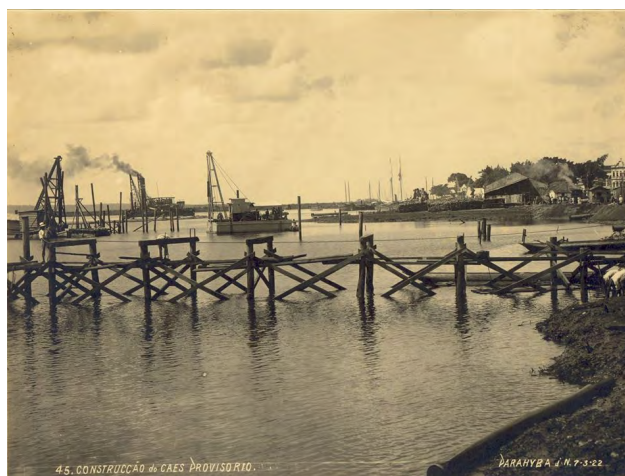
Figura 56. Construção do cais provisório, 1922. A fotografia busca contrapor a estrutura provisória com as operações de dragagem na bacia do ancoradouro, demonstrando o progresso mesmo em situações de precariedade.
