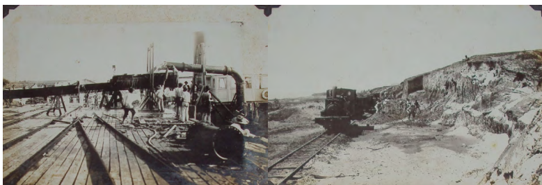
Figura 46. Procedimento de aterro por detrás do cais, 1927. Por mar (à esq.) e por terra (à dir.), contou com o uso da tecnologia para a efetivação das obras, em um duplo processo de destruição e criação, a chamada “destruição criativa” de Marshall Berman. 619
