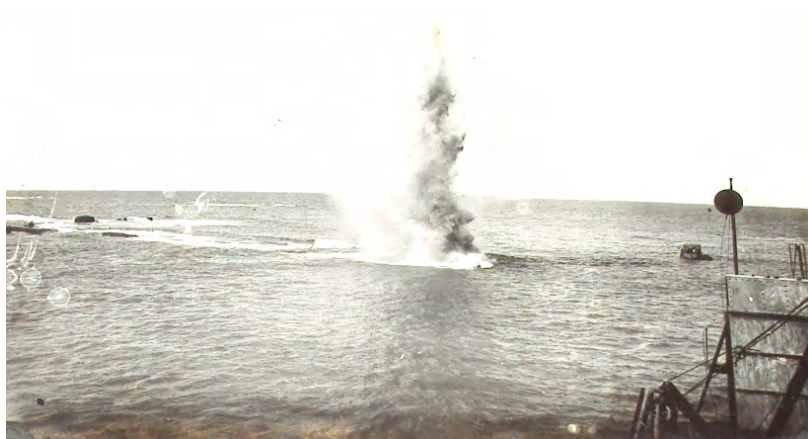
Figura 40. Explosão de uma mina para derrocamento da “Baixinha”, 1927. Os engenheiros evitaram o seu emprego, em decorrência dos efeitos colaterais de produção e posterior retirada de entulho em locais não planejados originalmente.
